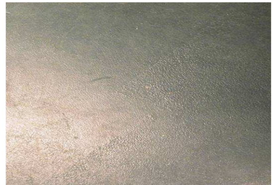
Afb. 5.11: Voorbeeld textuurverschil
